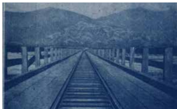
▲清水溪橋兼公路橋。（資料來源／臺鐵《業務通訊》第41號，1958年）
