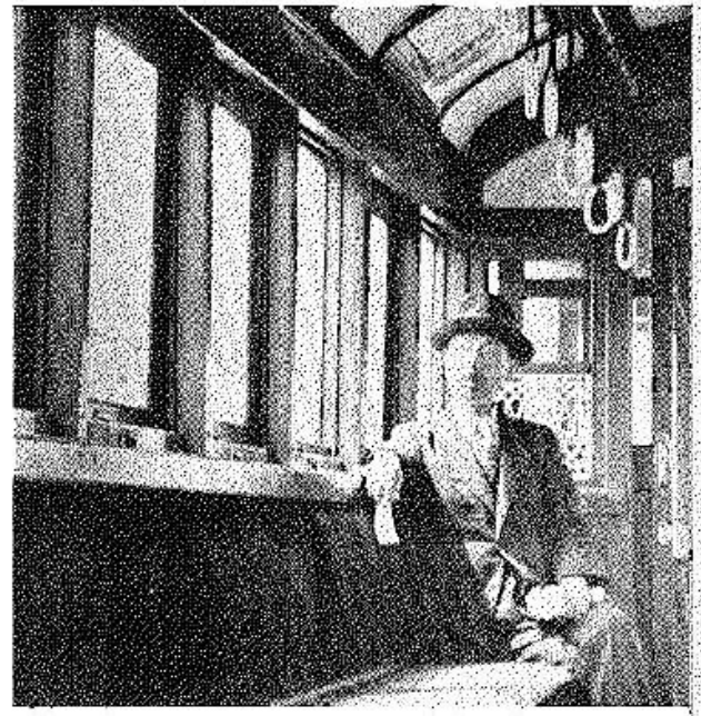
東京地下鐵車內（舊）
