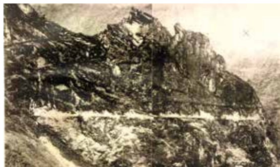
▲大安山軌道最困難的施工路段「天狗岩」，軌道上方還殘留路線勘查時架設的棧道。（圖片來源：《臺灣山林會報》）
