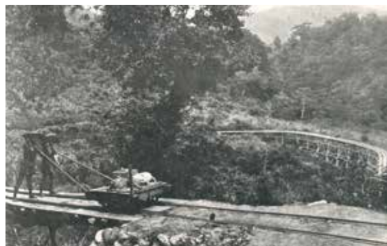
▲花蓮港鹿卡拉山道的螺旋輕便軌道。（圖片出處／《臺灣寫真帖》，1915年）
