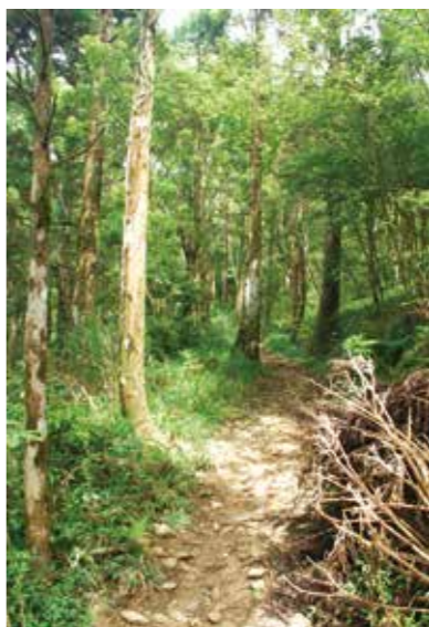
▲剛過中央山脈的浸水營道路路基。
