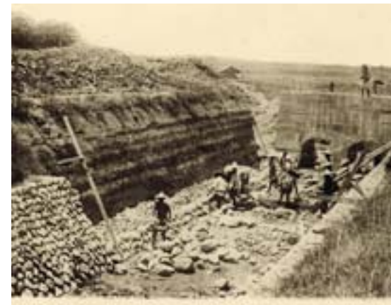
▲宜蘭第一公共埤圳改修工程。
