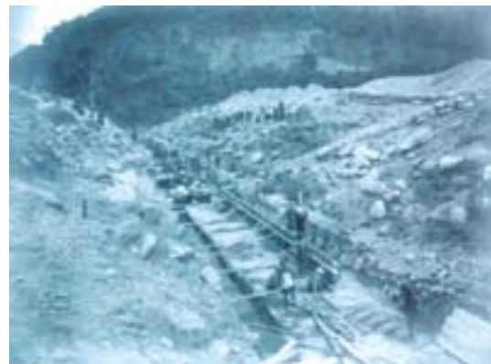
▲地下堰堤施工情形。(資料來源：資料來源：利用伏流水開發荒蕪地—臺灣製糖株式會社萬隆農場開墾經過，鳥居信平，1936)
