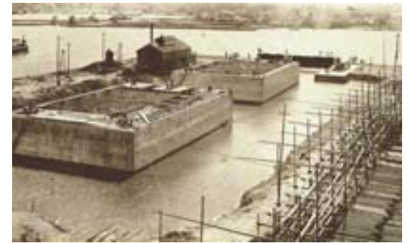
▲濁水溪河川工程。（圖片提供／國立臺灣圖書館）
