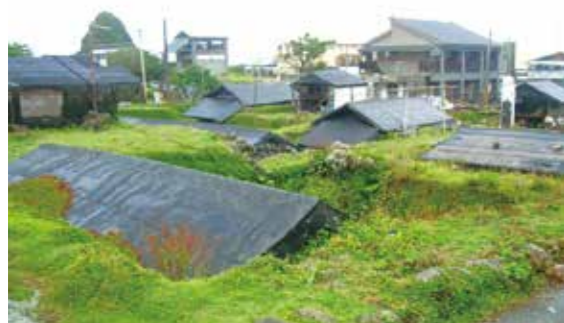
▲蘭嶼傳統地下住屋。
