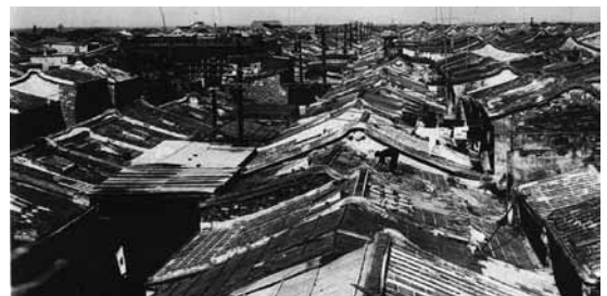
▲鹿港不見天街的屋頂櫛比鱗次，屋頂上方設有天窗，以利房屋採光。（照片提供：鹿港鎮公所）
