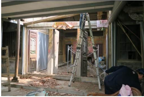
5月12日放晴，處理危險屋瓦及塌落桁條
