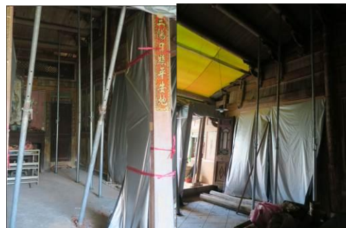
5月27日 暫時以伸縮鐵件支撐木棟架
