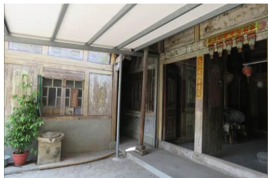
圖 3-3-9 軒亭拆除改搭鐵皮遮陽架
