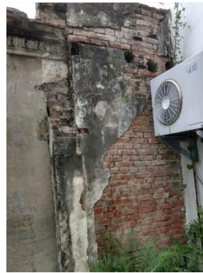
圖 3-3-25 後檐牆殘留橫向木搭在廊牆的孔洞
