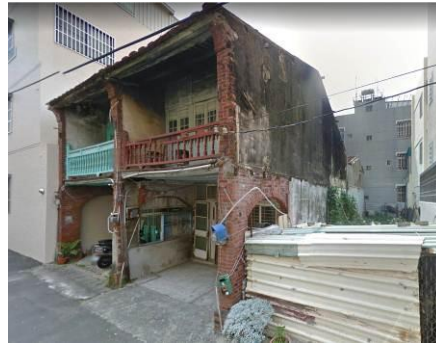
圖 3-3-19 砌築紅磚方柱圓拱廊騎樓相通
