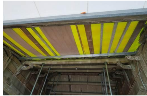
6月16日進一步於前坡以木條搭接補強
