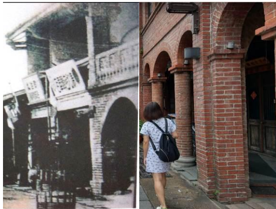
圖 3-3-21 三峽老街以紅磚築砌方柱單圓拱立面
