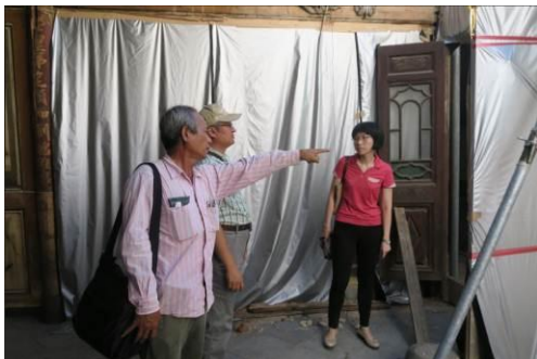
5月27日趙建築師確認暫時補強支撐架數量
