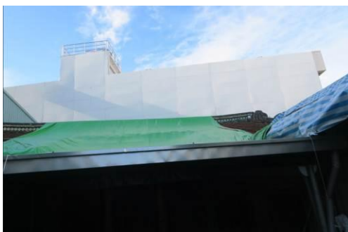
經費有限僅能訂製大型帆布，覆蓋正廳前後坡。
