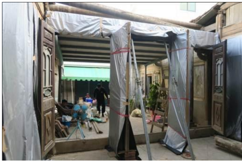
5月12日 中門、門楣等有顏料層之處，可能曝曬於紫外光下，均先以防紫外光布保護
