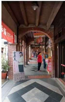
圖 3-3-20 頂部為木樑結構相搭承接二樓板
