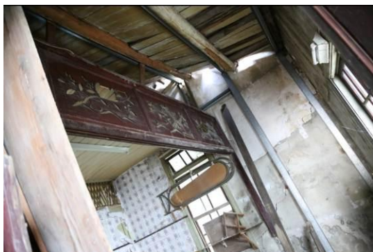
圖 3-3-8 正身木棟架以 C 型鋼進行加固
